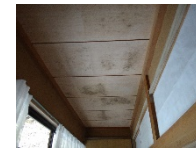
(a) 屋根裏侵入口と (b) 棲みつきによる天井汚損 柱の搔き傷
