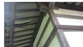
(a) 屋根裏侵入口と (b) 棲みつきによる天井汚損 柱の搔き傷
